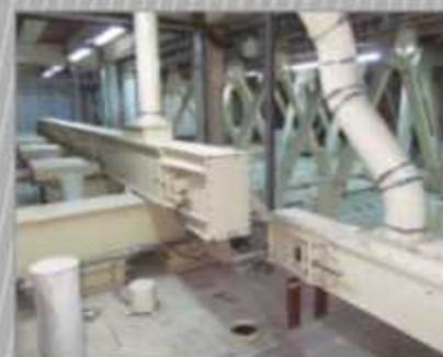
Convoyeur à chaîne Chain conveyor
