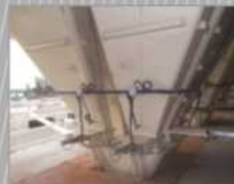
Trappe pneumatique sous silo Silo-pneumatic outlet slide
