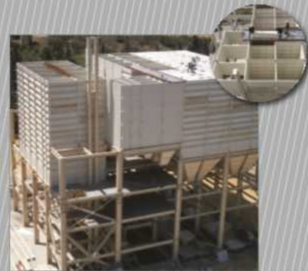
Silos prismatiques Square silos
